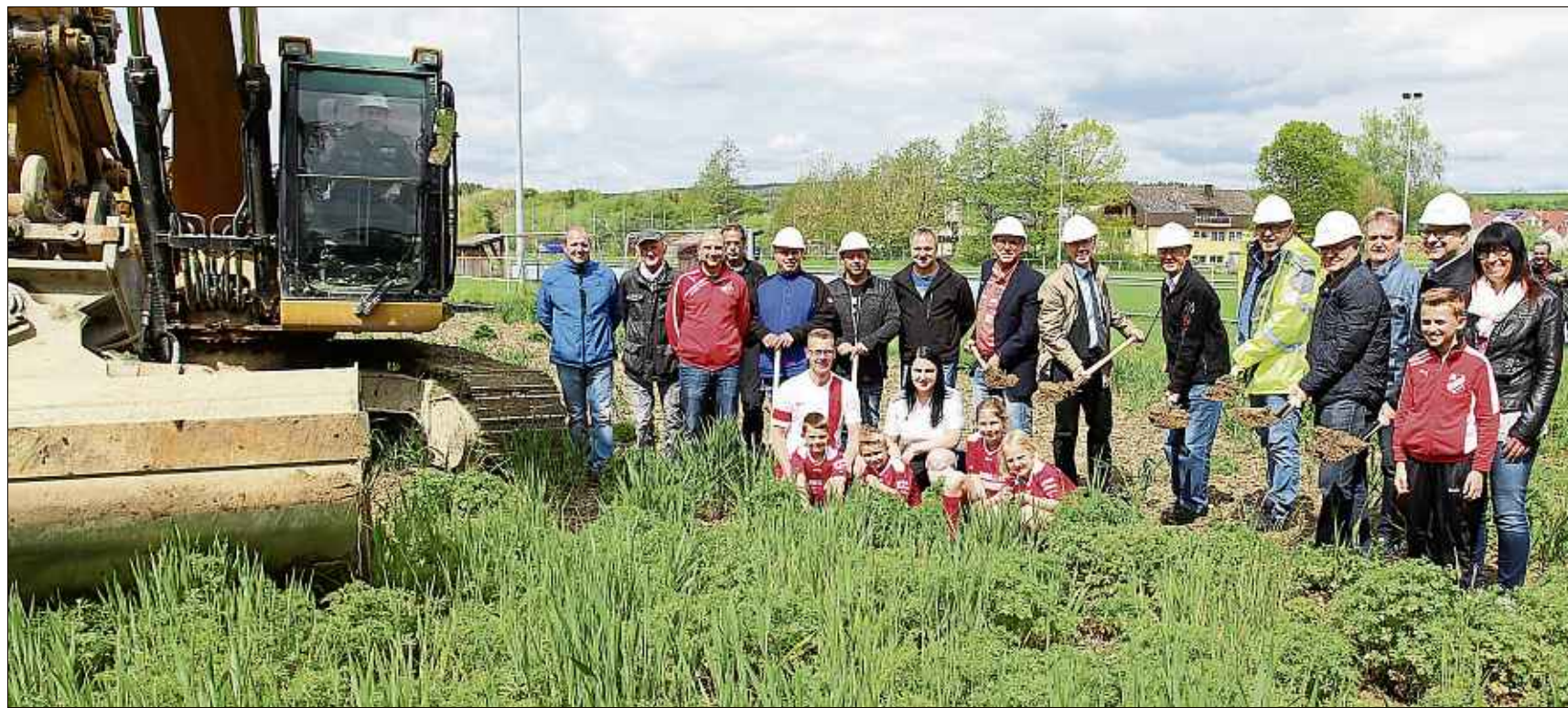
Seit 2007 ist das millionenteure »Infrastrukturprojekt Kunstrasen« in den Köpfen. Gestern nahmen Funktionäre des Sportvereins, der Gemeinde Eutingen, des Sportkreises Freudenstadt sowie Planer und Umsetzer den Spatenstich vor. Foto: Feinler
